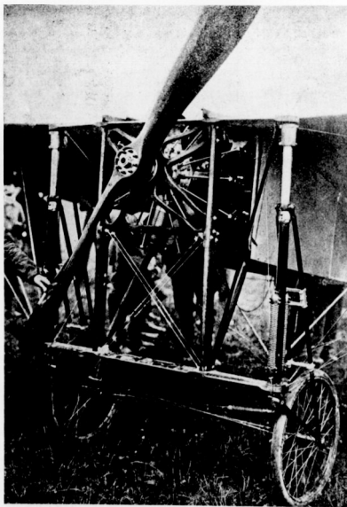
Az új 100 lóerős Gnome motor Morane Bleriot gépébe építve
