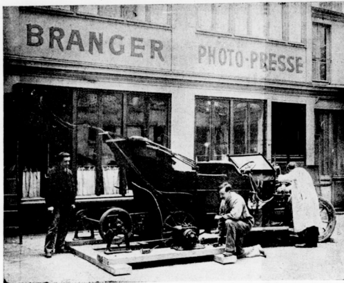
Az automobil alkalmazása a párisi árvíz idején. A Branger-cég áramfejlesztőgépet hajtja a motorrall.
