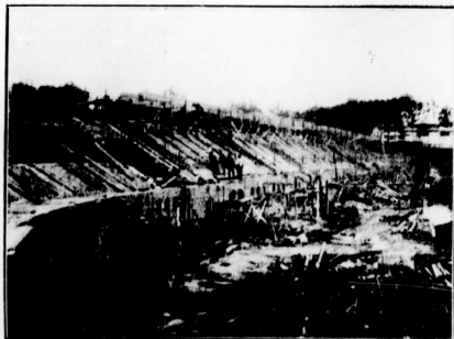
Az épülő stadion.
