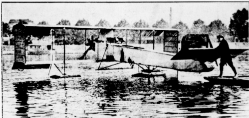
Voisin hidroplánna átalakított biplánja.
