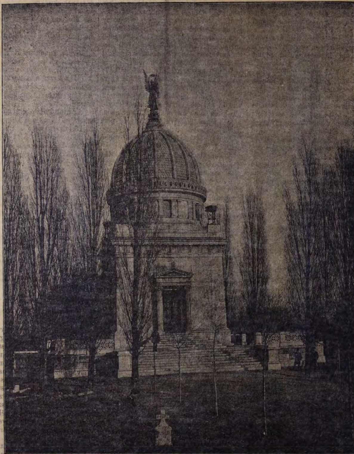
A DEÁK-MAUZOLEUM A KEREPESI-ÜTI TEMETŐBEN.
